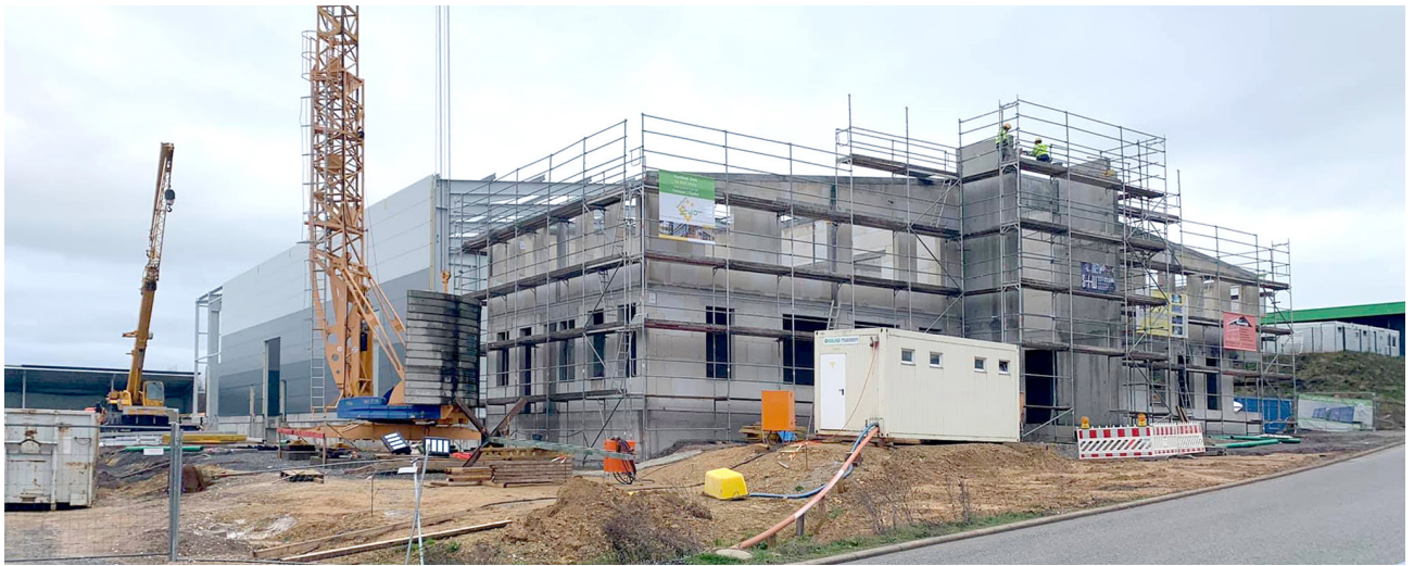
Bauphase des neuen Betriebsgeländes
